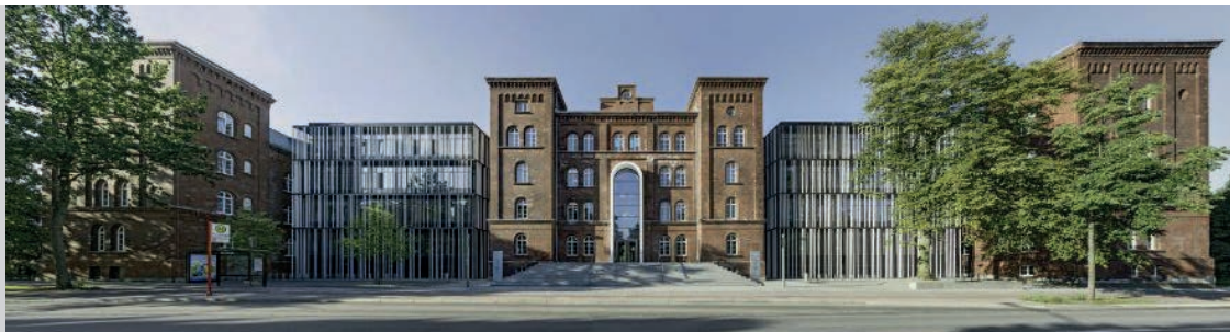
TU Hamburg, Hauptgebäude A
